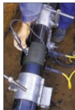
b) Électrosoudage sur PE
